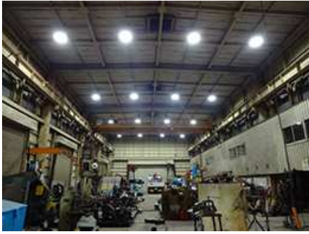
菊地工業所施工後
